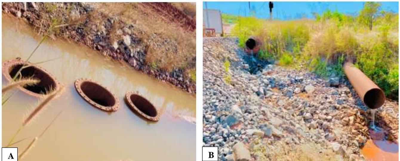
Figura 20: Vertedouros a norte. A) Vertedouros, B) Conduitas por onde desaguan (Autora, 2022)
